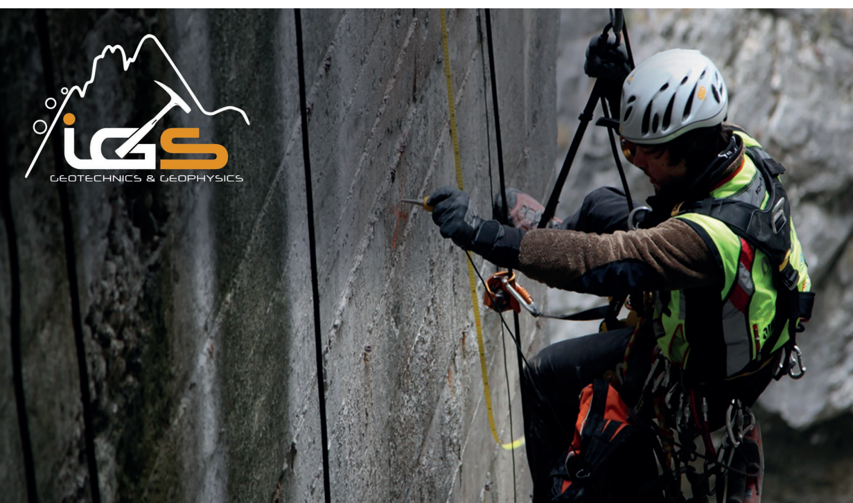
TECNICI DI IGS IMPEGNATI NELL'ESECUZIONE DI INDAGINI IN PARETE, A 200 METRI DA TERRA
